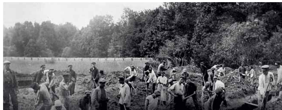
Начало строительства завода
